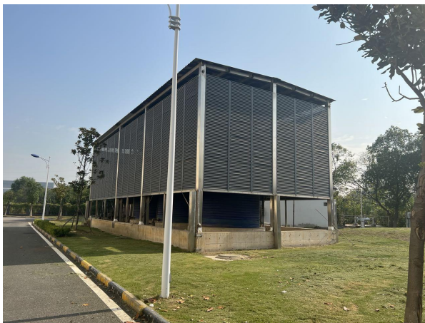
次氯酸钠储存间
