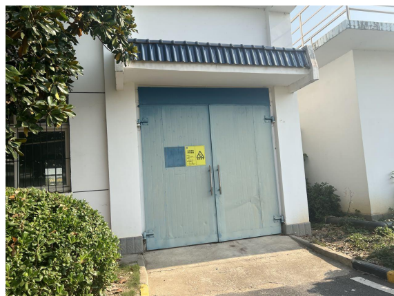
危险废物暂存间
